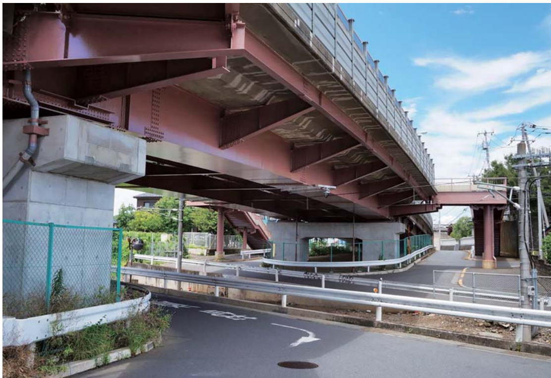
主要地方道八王子武蔵村山線（第59号）多摩大橋通り 小宮陸橋
