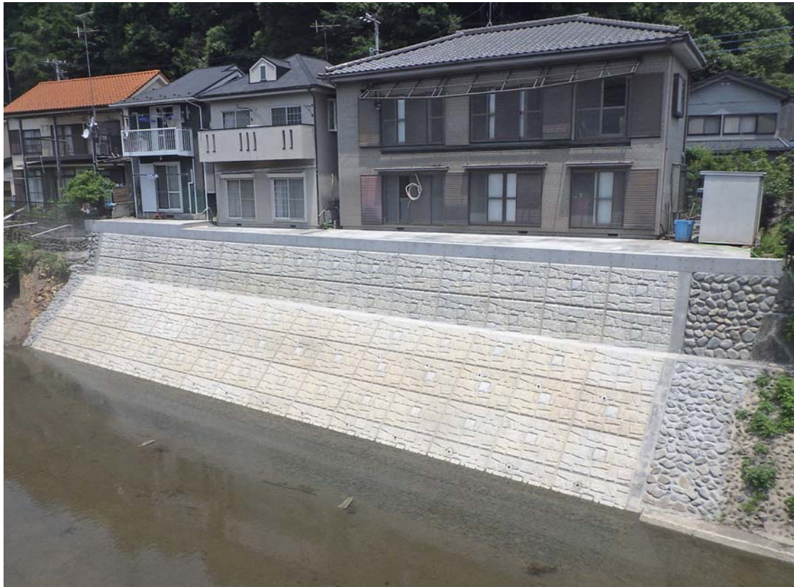
南浅川（八王子市廿里町地内 白山橋下流）
