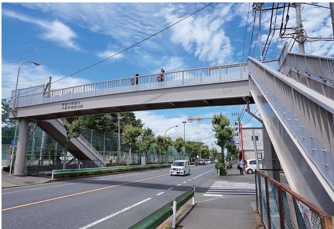
主要地方道八王子武蔵村山線（第59号）多摩大橋通り 石川歩道橋
