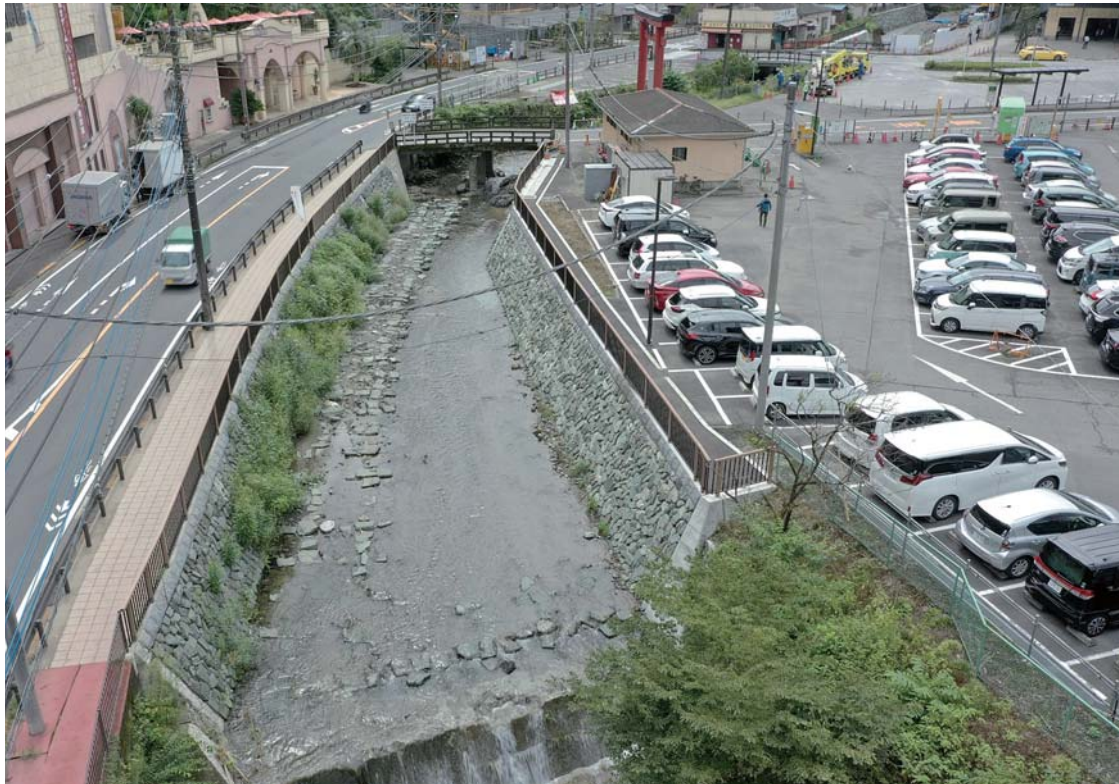
案内川（八王子市高尾地内 氷川橋下流）
