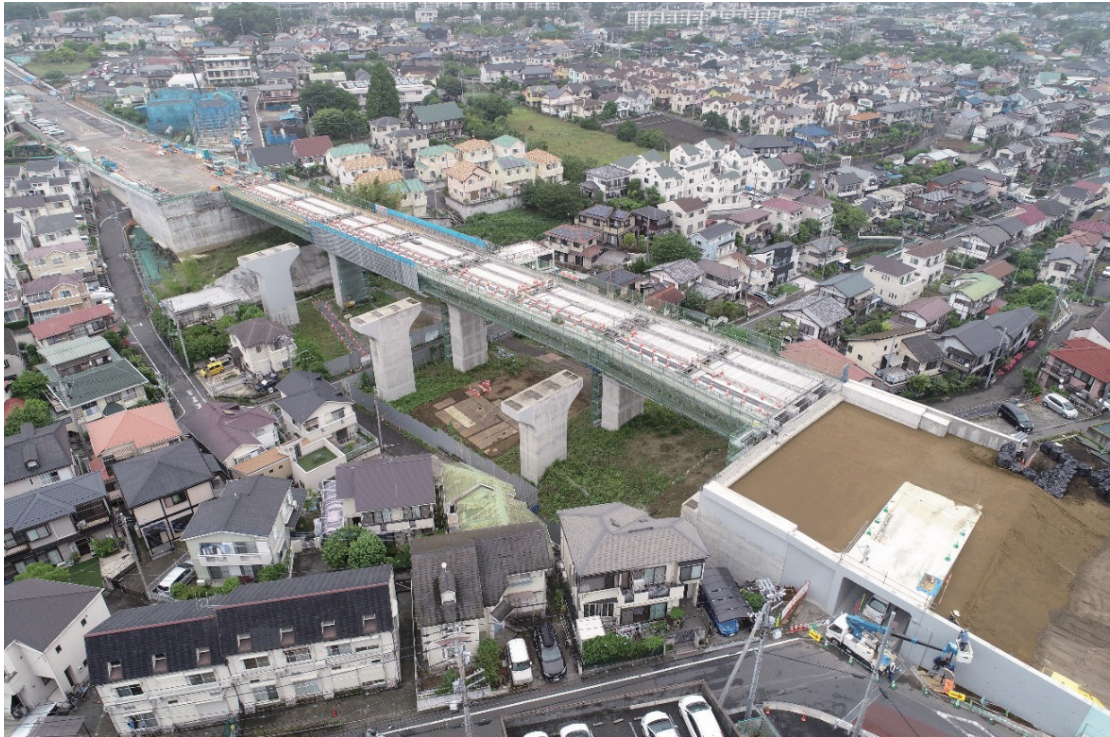
○町田3・3・36号〔旭町〕（相原鶴間線） 街路築造工事及び橋梁工事などを実施。
