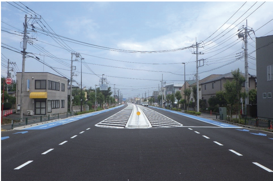
○主要地方道八王子町田線（第47号）町田街道〔小山Ⅱ期〕 本年度、歩道整備工事を進める。
