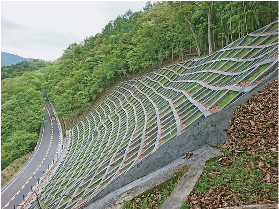
道路災害防除事業（一206-96上斜面） 「一般都道川野上川乗線（第206号）奥多摩周遊道路」 西多摩郡奥多摩町原地内 令和2年3月完成
