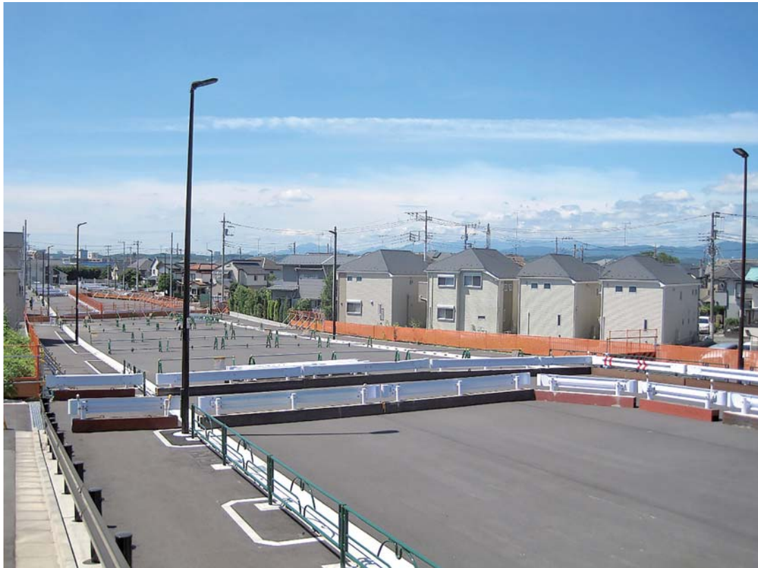
街路整備事業 「福生3・3・30号」 福生市福生地内 平成30年6月現在
