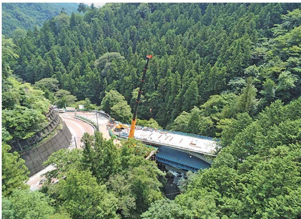
4号橋 (RCアーチ橋) 架設工事箇所
