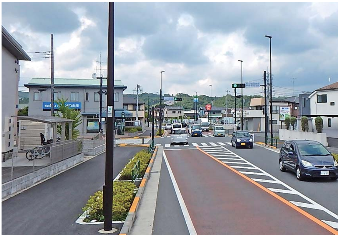
交通安全施設事業（すいすい日の出団地前） 「一般都道 山田平井線（第185号）」 西多摩郡日の出町平井地内 令和3年5月完成
