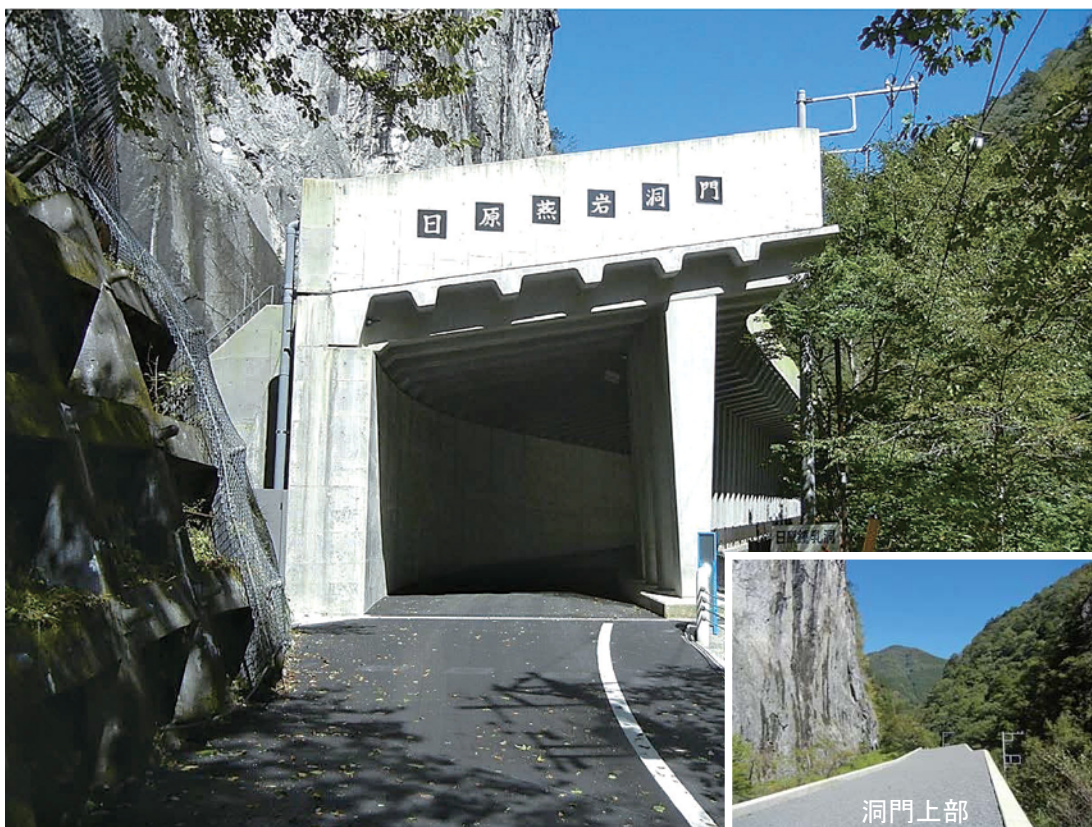
道路災害防除事業（日原燕岩洞門） 「一般都道日原鍾乳洞線（第204号）日原街道」 西多摩郡奥多摩町日原地内 平成30年9月完成（平成30年10月1日交通開放）
