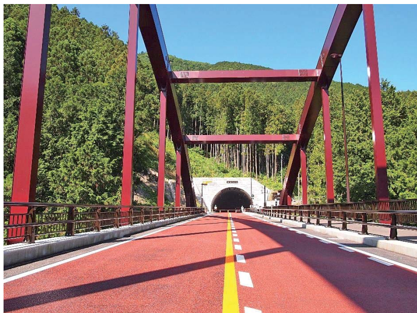
（将門大橋と城山トンネル坑口）
