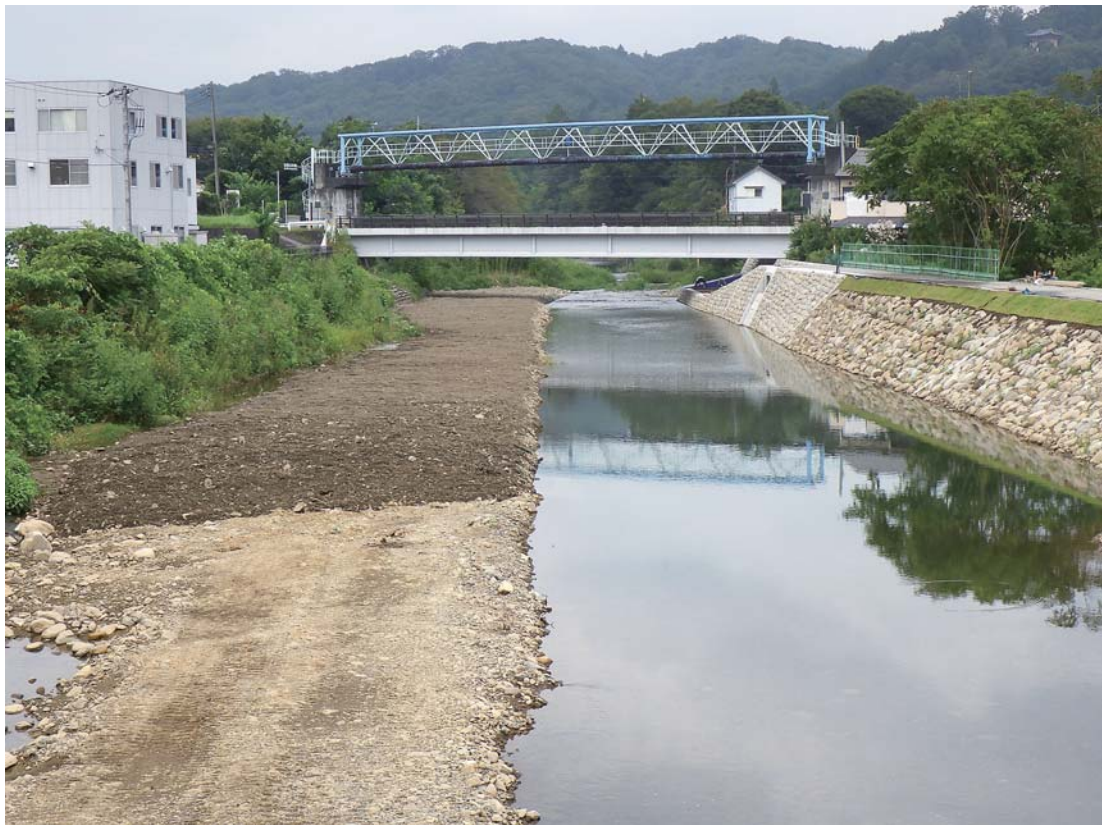
中小河川整備事業 「平井川整備工事」 (あきる野市菅生地内) 令和3年8月
