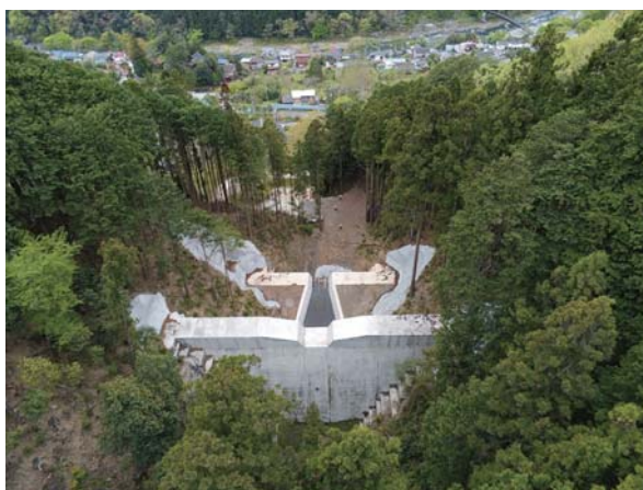
中曽川(えん堤)
