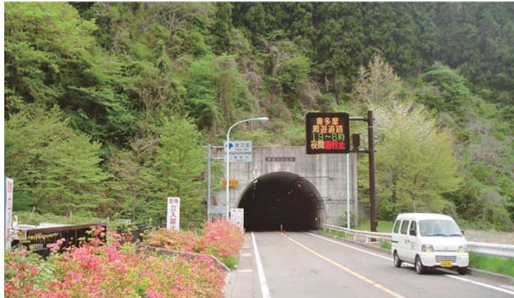
交通安全施設事業(道路情報提供装置) 「主要地方道第33号上野原あきる野線」 (檜原村南郷地内)
