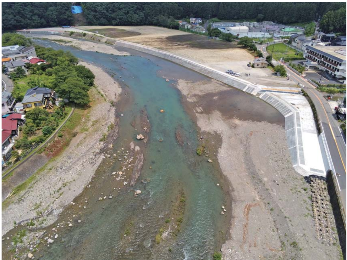
災害復旧事業 「秋川災害復旧工事」 （あきる野市小和田地内） 令和3年7月
