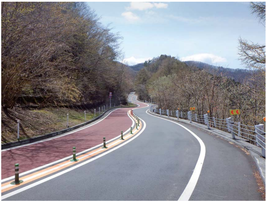
路面補修事業 「一般都道川野上川乗線（第206号）奥多摩周遊道路」 西多摩郡檜原村倉掛地内 令和2年11月完成
