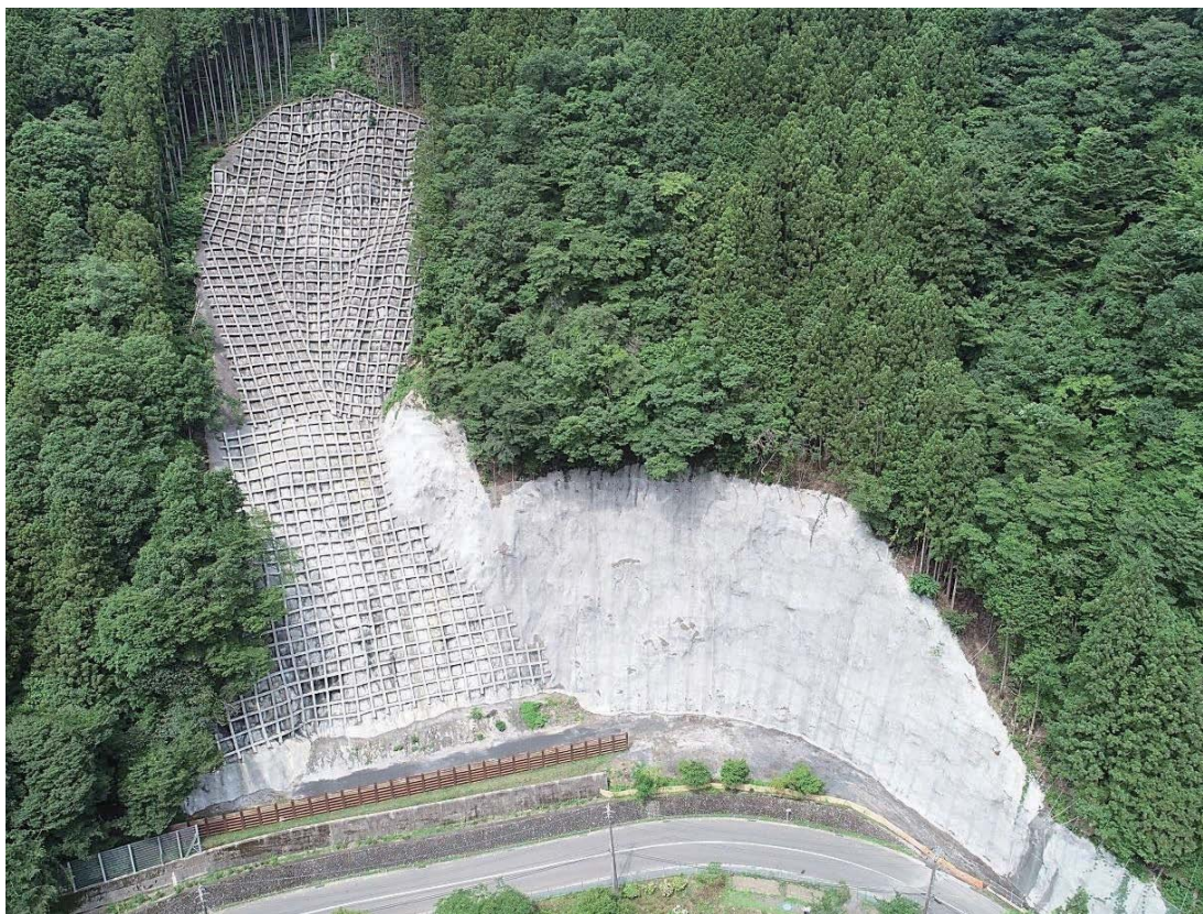
道路災害防除事業（一205-59上斜面） 「一般都道水根本宿線（第205号）」 西多摩郡檜原村樋里地内 平成30年7月完成
