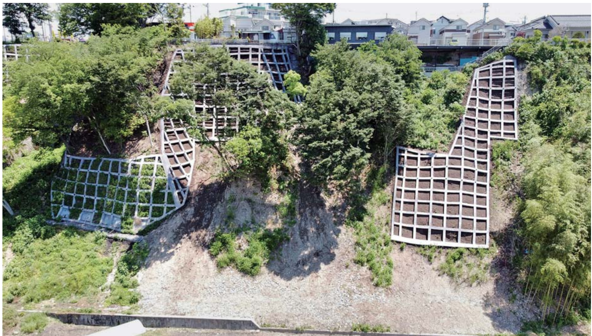
急傾斜地事業 「河辺町一丁目地区」 (青梅市河辺町一丁目地内) 令和3年6月
