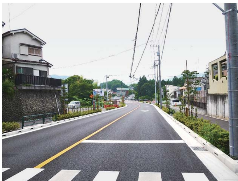
(整備が完了した凱旋橋付近)
