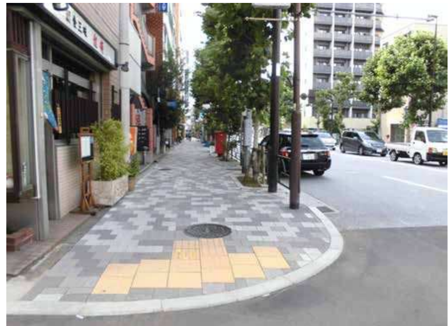
無電柱化後の舗装復旧に併せた歩道のバリアフリー化(早稲田通り)
