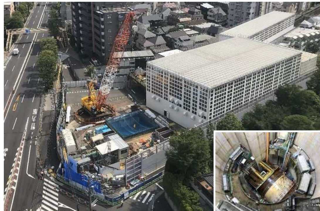
環状七号線地下広域調節池(石神井川区間)工事 (中野区野方五丁目)
