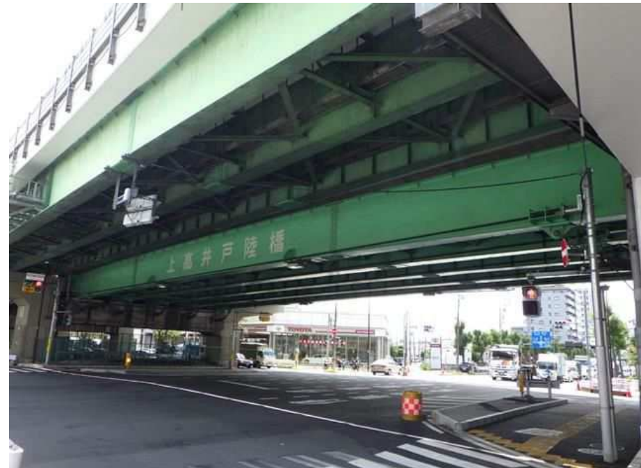
橋梁の長寿命化(上高井戸陸橋)
