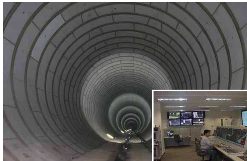
神田川・環状七号線地下調節池の本体トンネルと善福寺川取水施設の遠方監視操作システム
