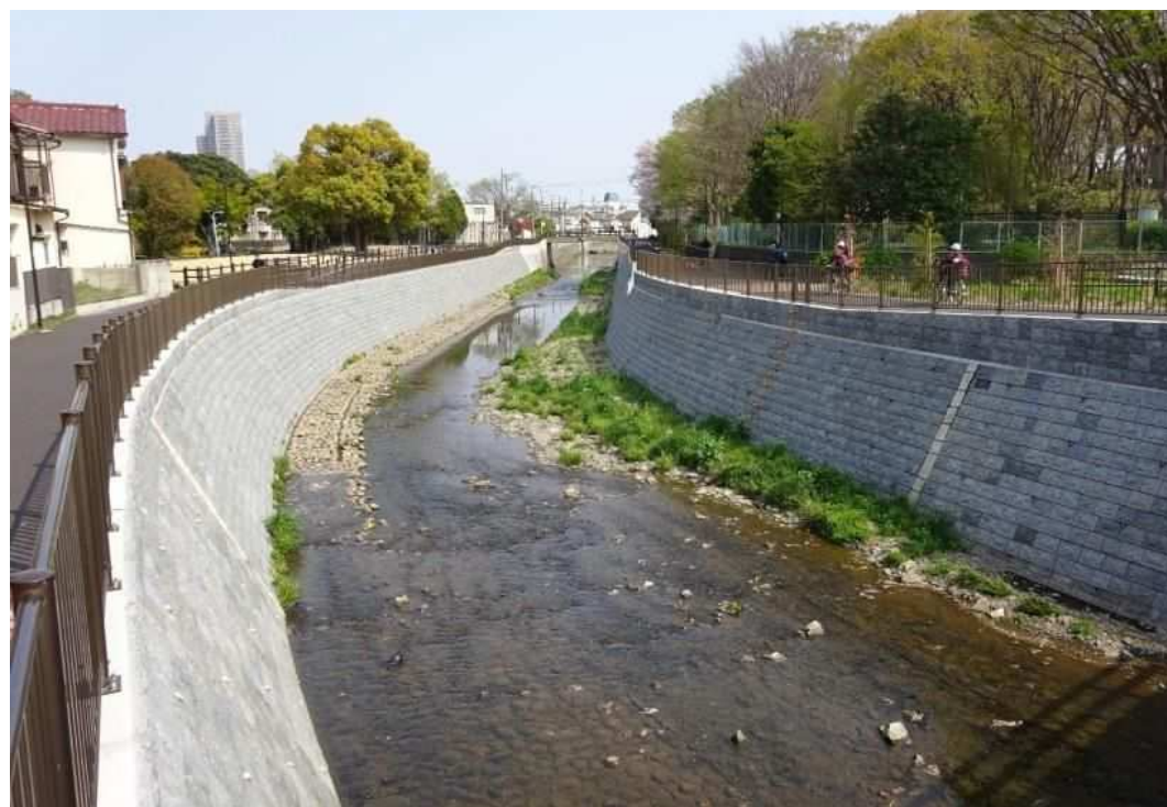
善福寺川整備工事(二枚橋より済美橋を望む) (杉並区大宮一丁目から堀ノ内二丁目地内)
