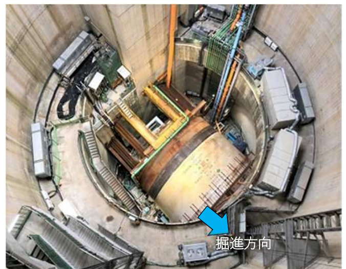
【発進立坑内のシールドマシン (令和3年10月現在)】
