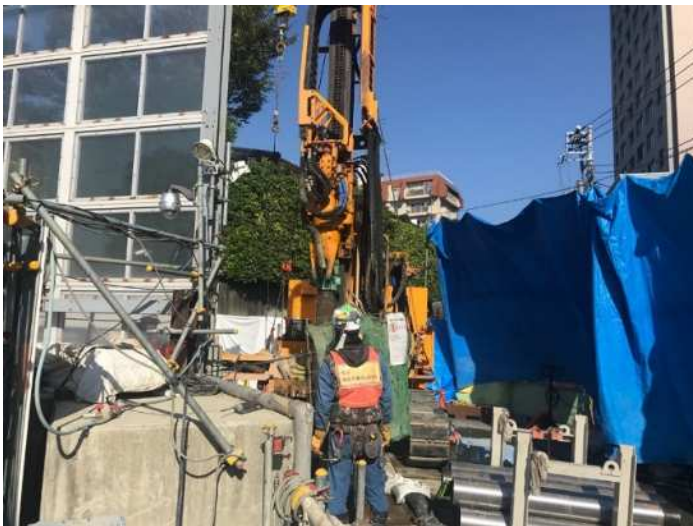
【地盤改良のための削孔状況 (令和3年10月)】
