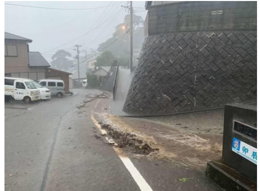
図3. 排水溝上部に落葉が堆積し機能不全を起こしている様子。 直営の事前清掃等で被害軽減に努めている。
