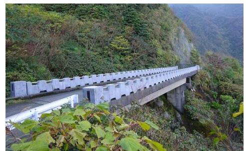
図 2. 御蔵島島内 「大島分橋」 大自然の中に架設された重厚な橋梁
