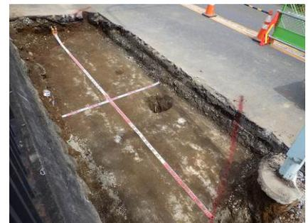
写真－5. 発見した埋設コンクリート
