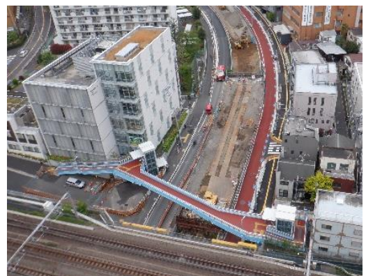
写真-3 完成した歩道橋と補助第74号線(西側)ビル屋上から(令和3年4月撮影)
