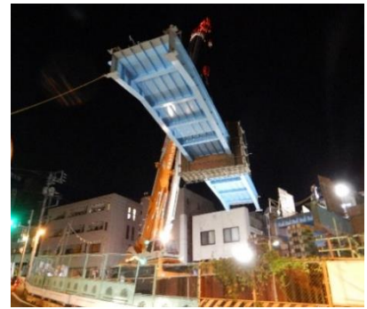
写真-2 橋桁架設(令和元年9月撮影)
