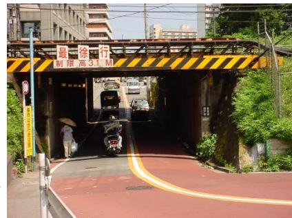
写真-1 工事着手前の鉄道交差部西側(平成 14 年撮影)
