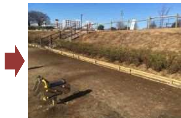
法尻に丸太土留めと低木植栽、法肩に木柵を設置
