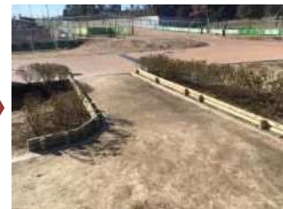
危険性のあった既設土留めも併せて改修
