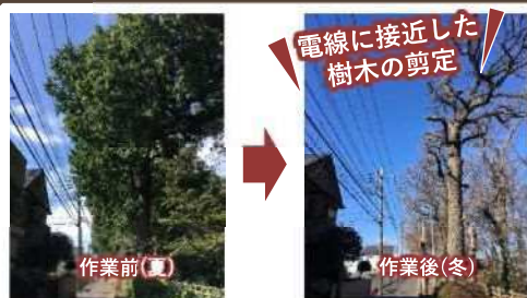
電線に接近した樹木の剪定を実施。春には葉が茂り、景観が保てる
