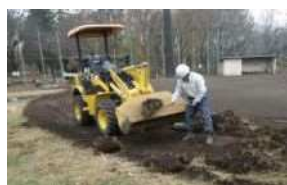
芝の剥ぎ取り状況
