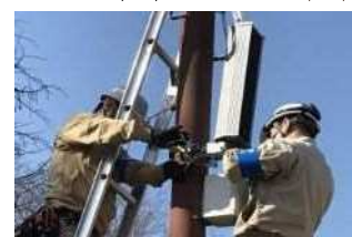
スピーカー交換により音質・音量も改善
