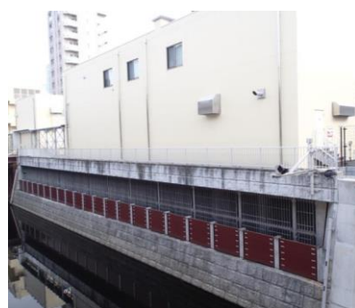
養老橋下流右岸取水口
