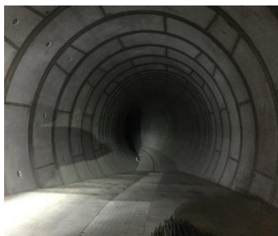
古川地下調節池内部
