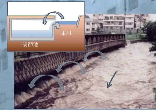
増水した川の水を一時的に取り込み、洪水の量を減らす調節池の整備を進めています。
