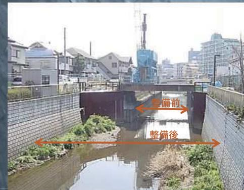
川の断面を大きくし、洪水を安全に流下させるための護岸整備を進めています。
