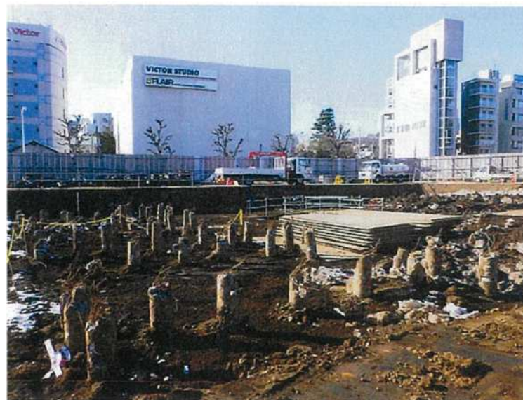
【霞ヶ丘アパート8号棟杭撤去前状況】
