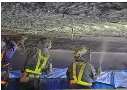
写真-11 断面修復工状況(乾式吹付け)
