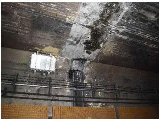
写真-21 漏水(日比谷地下自動車道)
