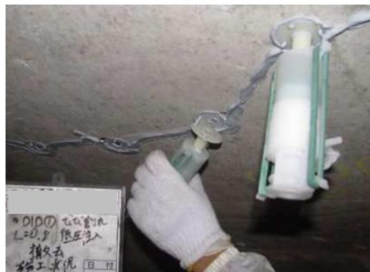
写真-8 ひびわれ注入工状況(低圧注入)
