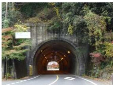
写真-2 在来工法(矢板工法)
