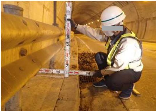
写真-15 異常時点検(ガードレール支柱腐食)
