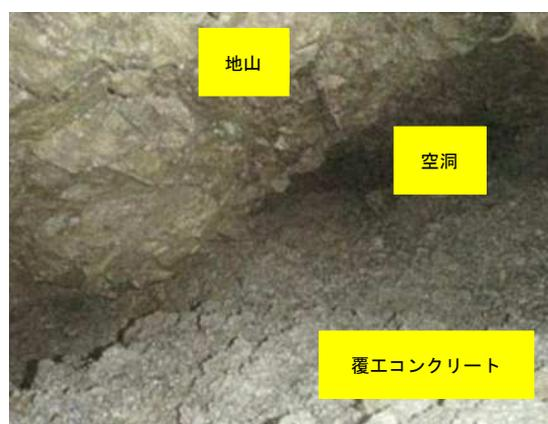
写真-4 覆工コンクリート背面の空洞
