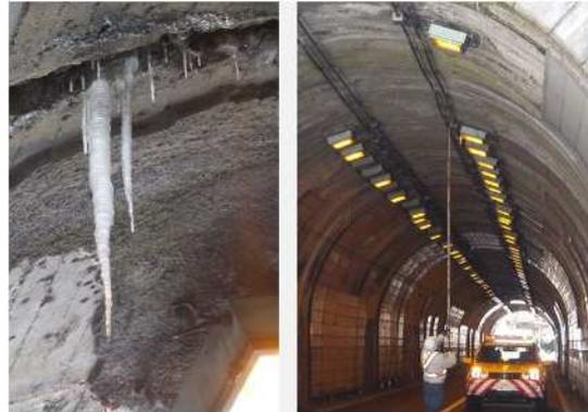
写真-16 応急措置(つららの除去)
