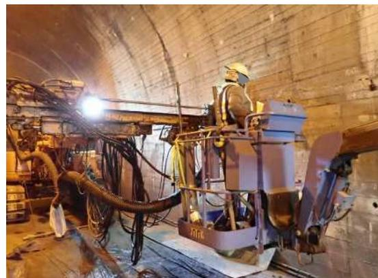
写真-10 ロックボルト工状況(削孔)
