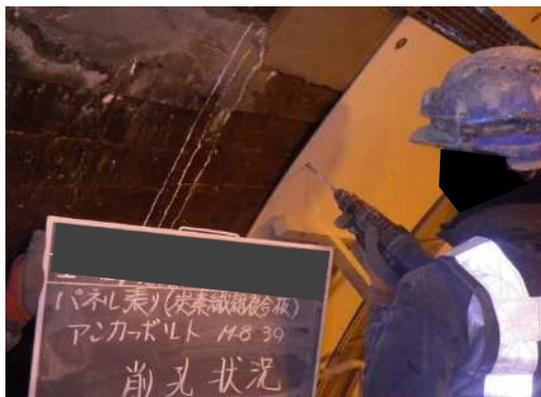
写真-9 内面補強工状況(成形板設置)
