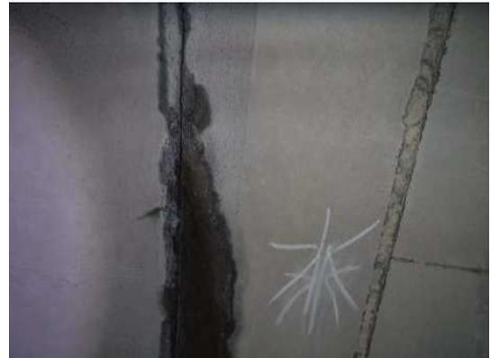
写真-20 漏水(岡田トンネル)
