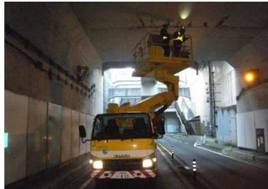
写真-14 定期点検の実施状況(近接目視)
