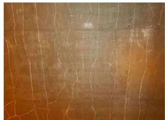
写真-22 ひび割れ(日比谷地下自動車道)
