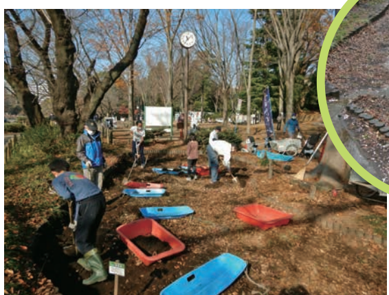
(左) 浸透地の泥上げ (右) 泥水が流れ込む様子
