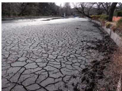
干しあがってできた底泥のひび割れ
