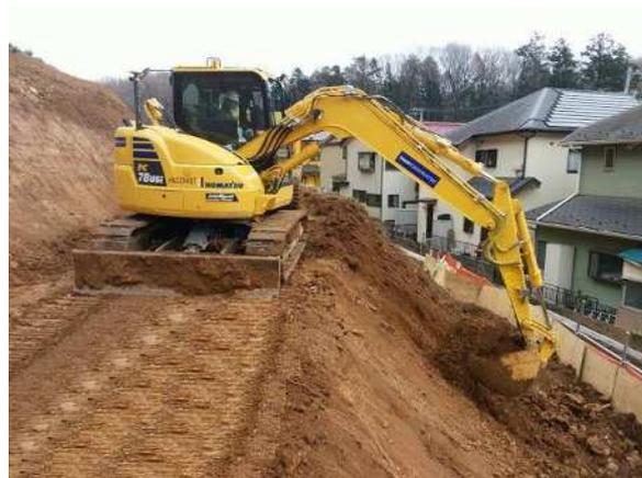
写真-2 小型ICT建機による掘削
