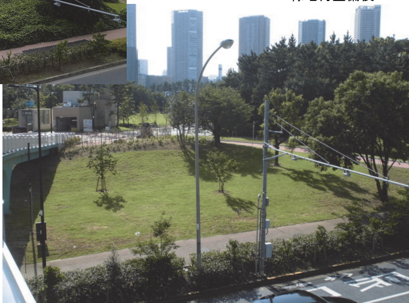
緑地再整備後
