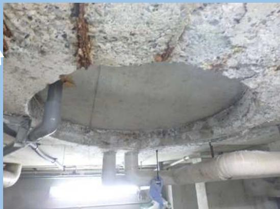
③鉄筋の腐食、コンクリートの劣化
