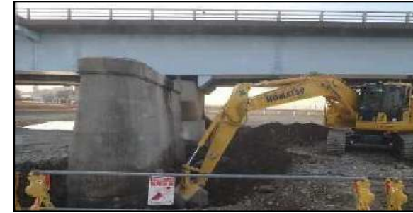
橋脚躯体部掘削状況
