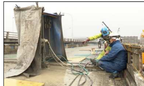
桁切断状況
