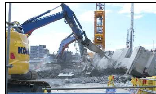
桁取壊し状況
