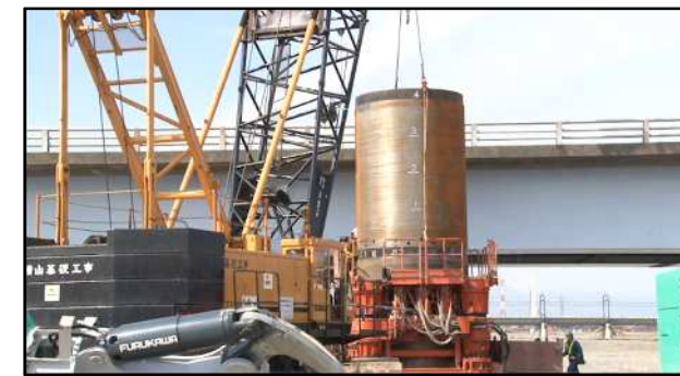
ケーシングチューブ据付け状況
