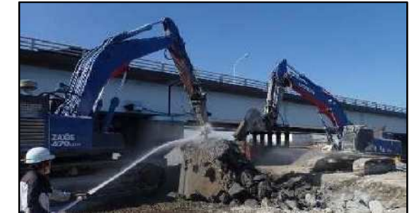
躯体取壊し状況
