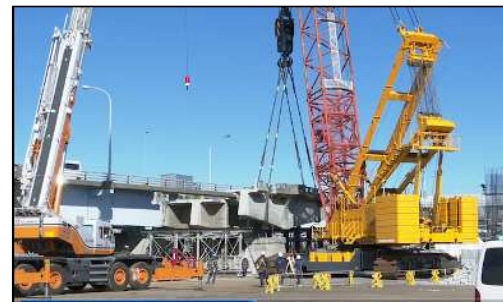
桁吊上げ状況
