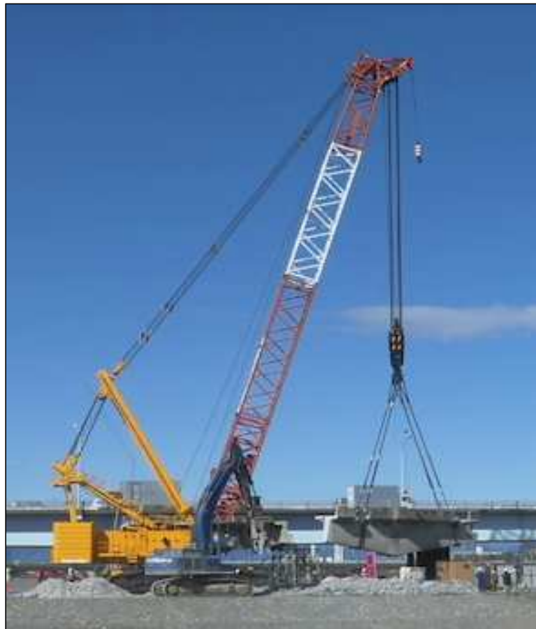
桁吊おろし状況
