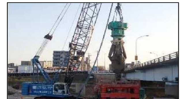
油圧式圧砕機による基礎撤去状況
