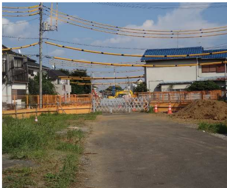
西東京3・4・9 現在の状況
