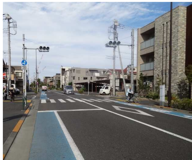
無電柱化・自転車レーンのイメージ 武蔵野3・4・24:幅員16m、歩道幅員3.5m
