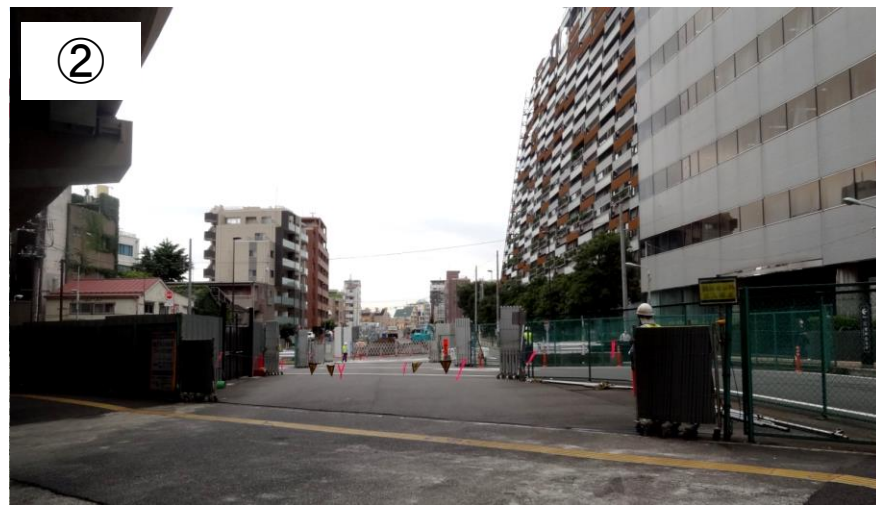
② 終点側(豊島区役所側)
