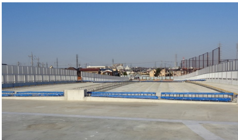
跨線橋桁架設状況
