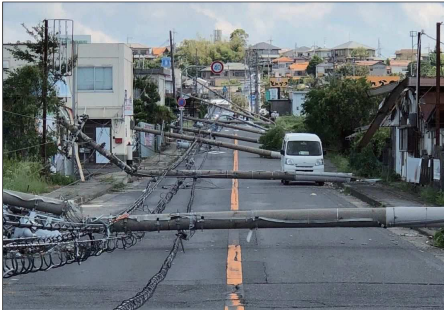
平成30年台風第21号(大阪府泉南市)
