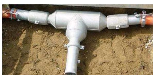
図2-6 直埋T分岐の例
