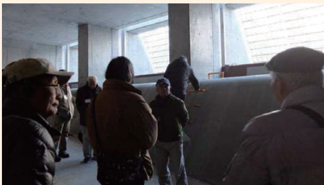
入間川分水路の流入口
