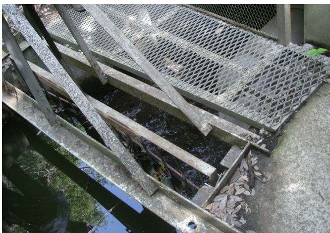
大池の出口から JR をくぐるトンネル
