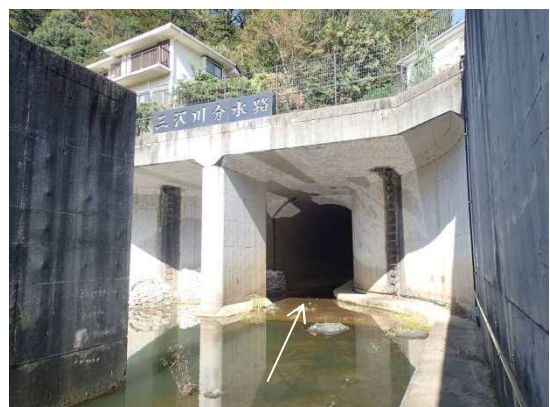
分水路取水口
