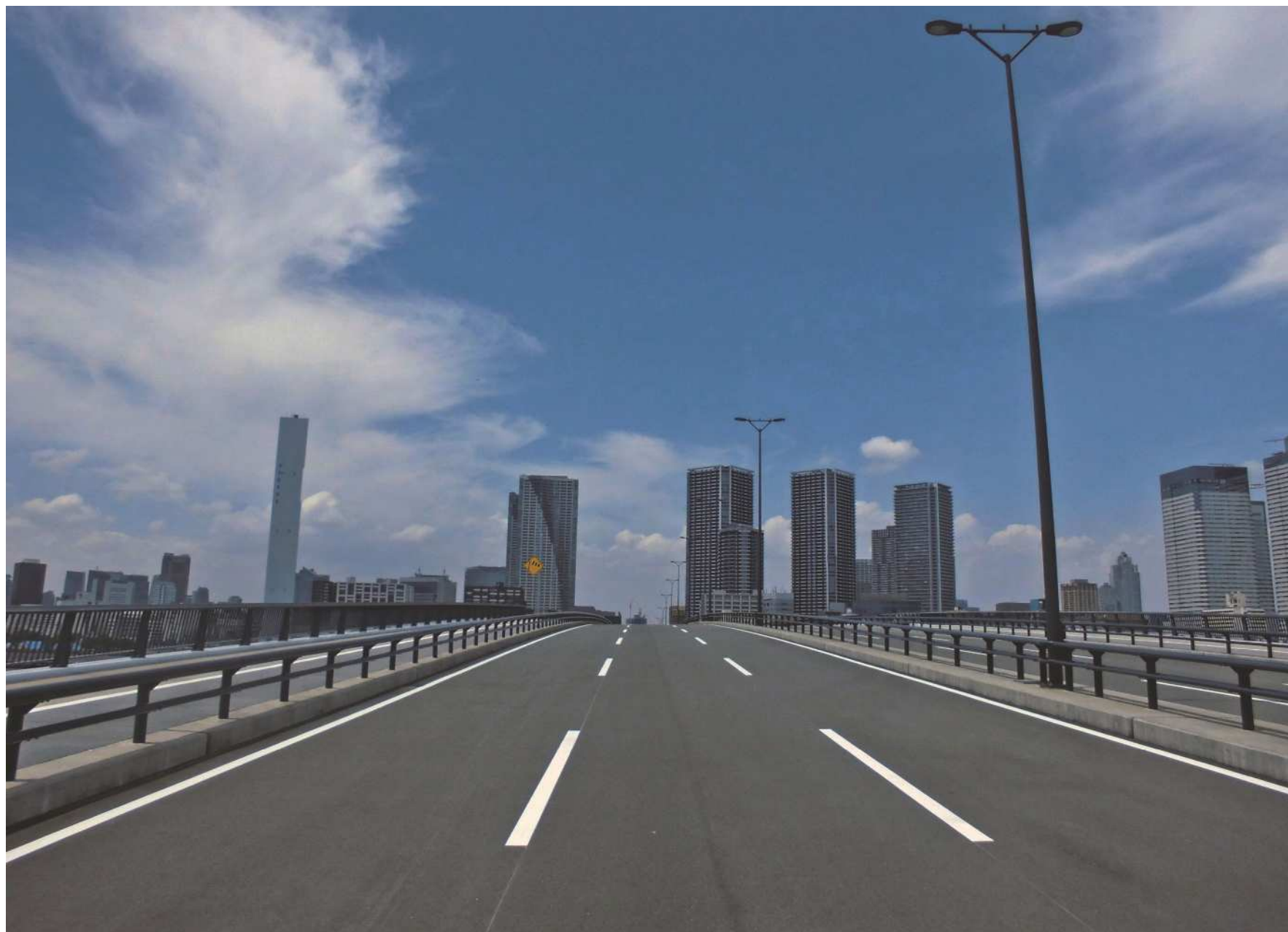
交通安全施設工事も完了し開通を待つ豊洲大橋(豊洲側から晴海方面を望む)
