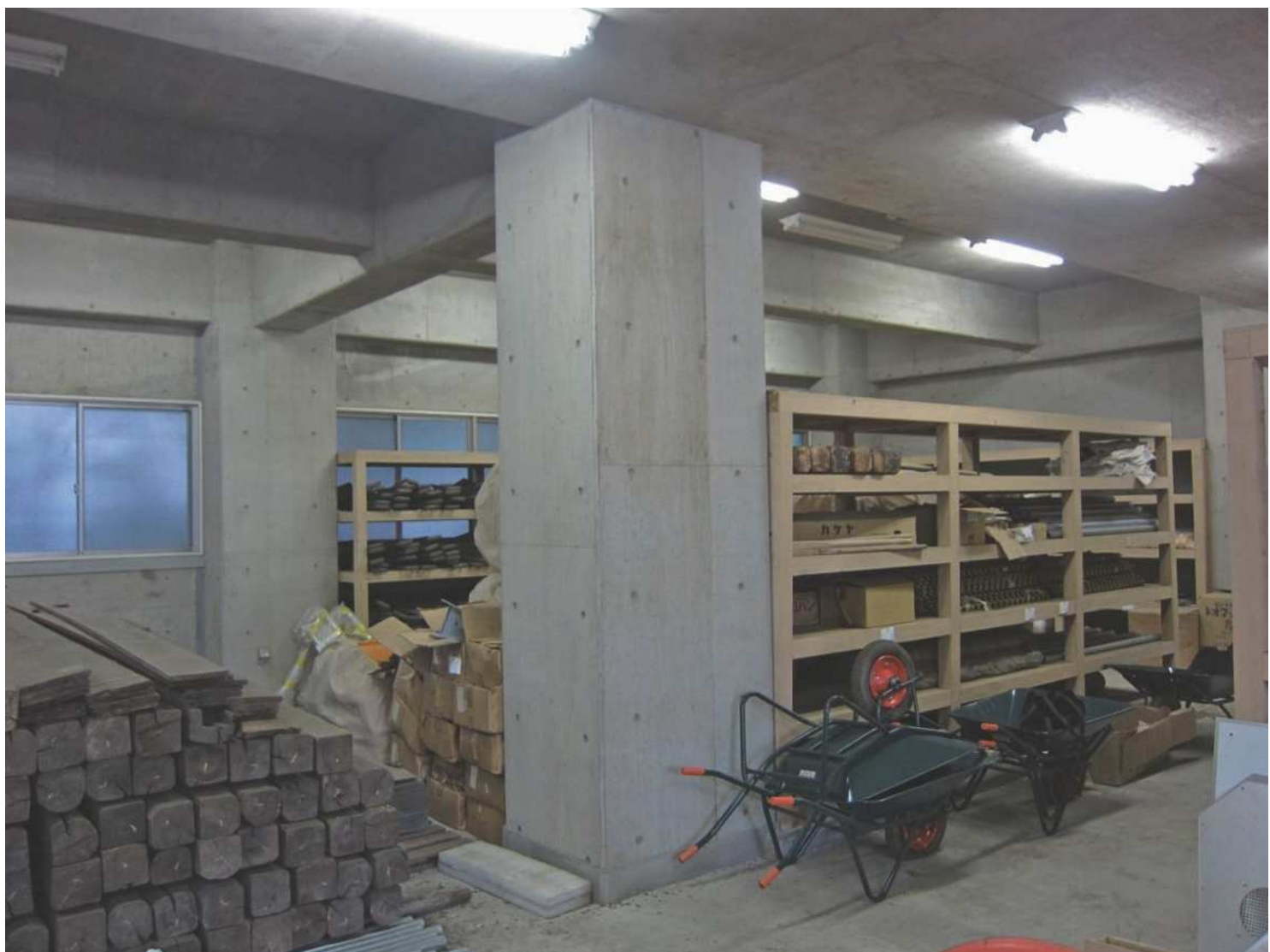
水防倉庫（墨田工区）
