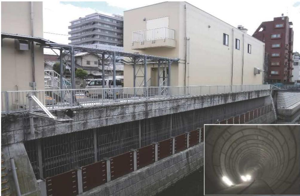
〔河川整備〕 古川地下調節池 取水施設と地下トンネル
