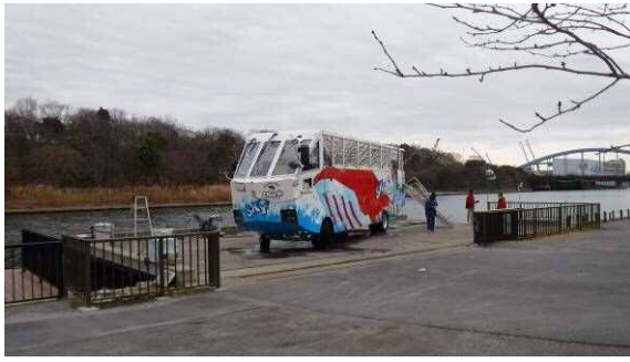
水陸両用車の川へ出入りするためのスロープ
