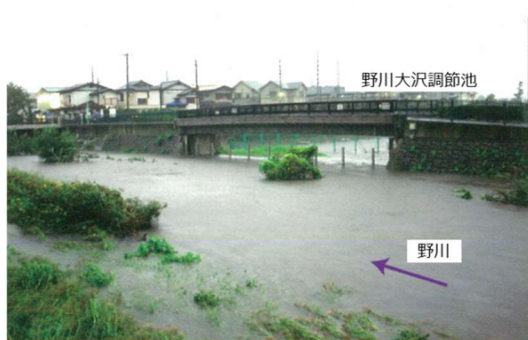
野川大沢調節池の越流堤(洪水時)
