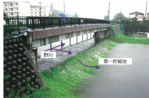
野川からの取水状況(洪水時)
