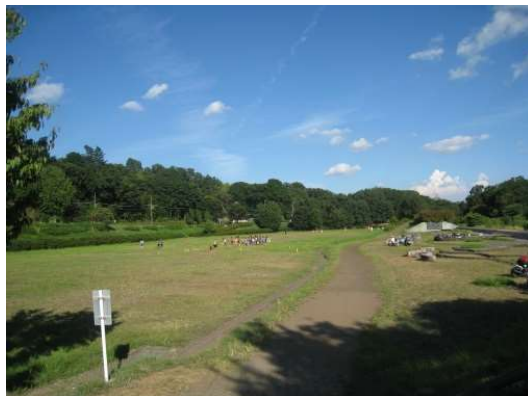
野川第二調節池全景
