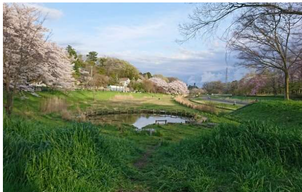
野川第一調節池（西側、写真右奥に見えるのが越流堤）
