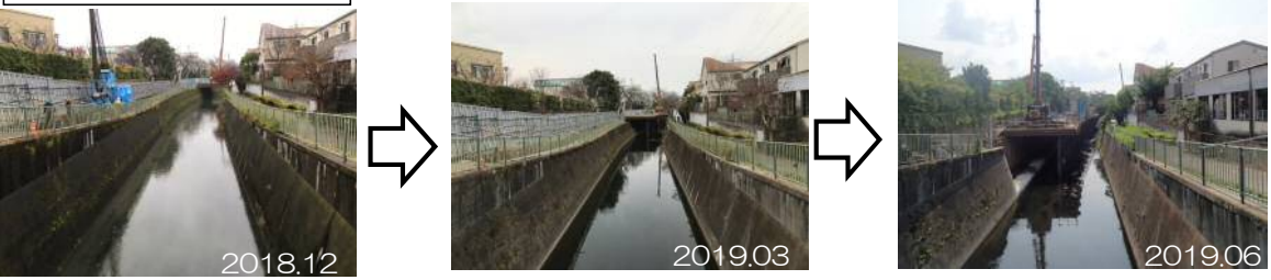
搬出入路工事
