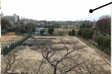
調節池本体工事
