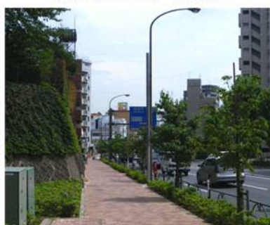
⑥舗装復旧工事【完成】
