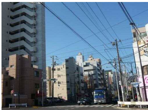
図 1-1 林立する電柱と輻輳する電線 (清洲橋通り<江東区扇橋>)
