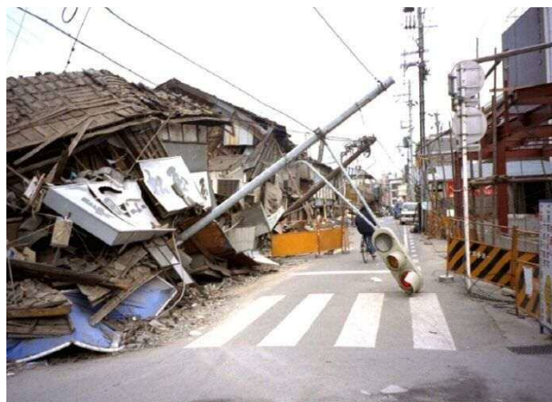
図 1-2 阪神・淡路大震災で倒壊した電柱 (出典：国土交通省ホームページ) http://www.mlit.go.jp/road/road/traffic/chicyuka/mokuteki_02.htm
