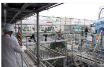
中間立坑の最上部
