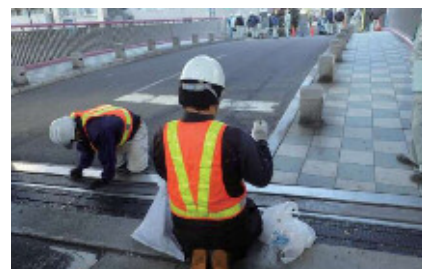
防水扉のレールを点検している様子
