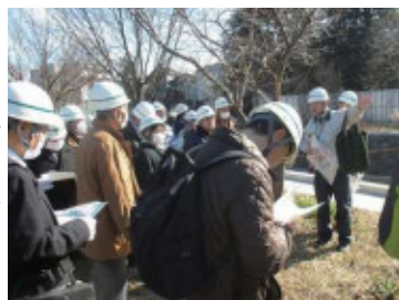
護岸整備工事箇所
