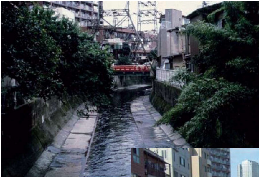
神田川 ( 中野新橋付近 ) : 工事改修前
