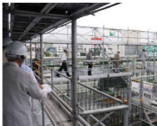
中間立坑の最上部
