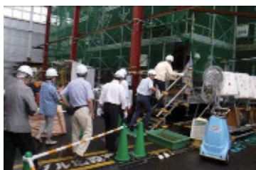
現場見学会：ここから中間立坑を上っていく
