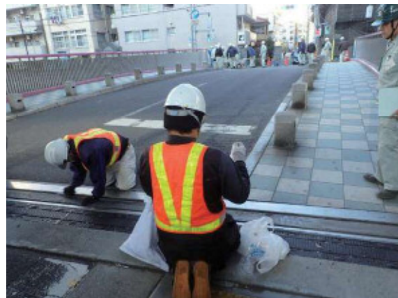
防水扉のレールを点検している様子
