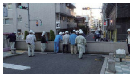
閉まった防水扉
