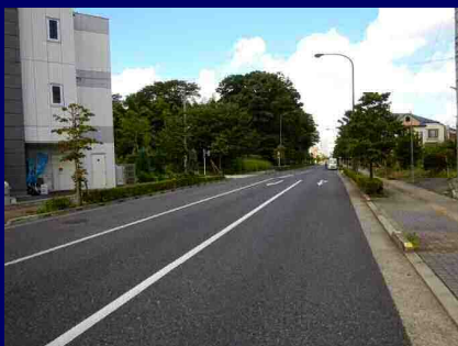
西側 整備済道路 (西東京3・4・13号線)
