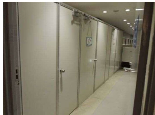
廊下の一部分に後付けで整備した授乳室
