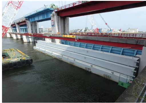
上平井水門耐震補強工事（施工中）
