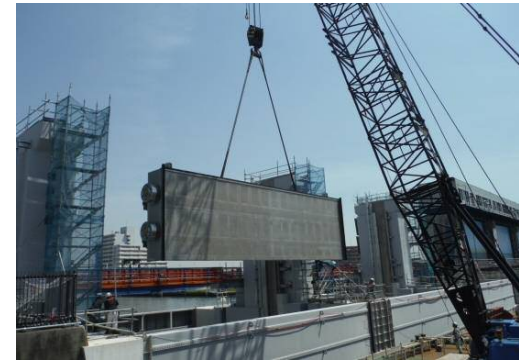
今井水門耐震補強工事（施工中）
