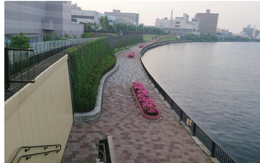
隅田川 新神谷橋上流右岸の防潮堤(北区)
