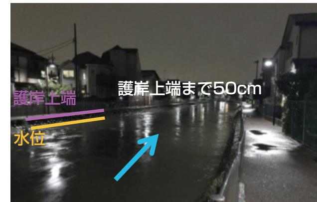
水位上昇状況(善福寺川 西田端橋付近)
