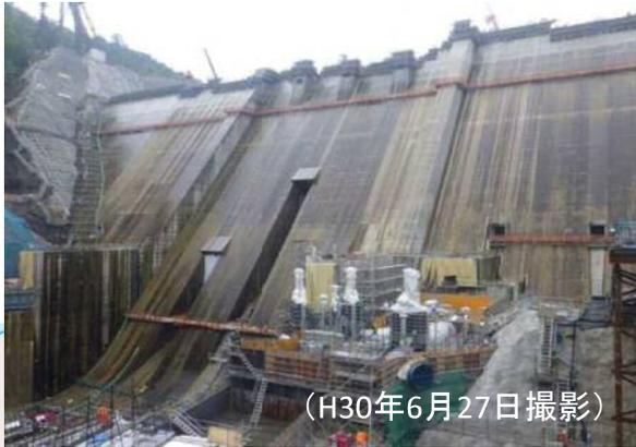
堤高116mのうち、約7割～8割の高さまでコンクリート打設が進捗
