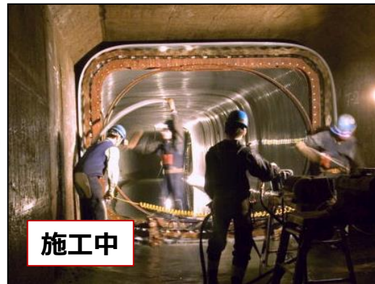
更生工法（ SPR工法 ）による再構築
