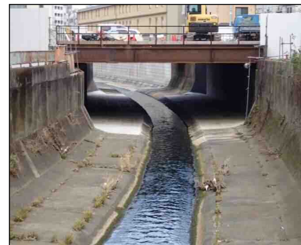
※神田川での施工事例
