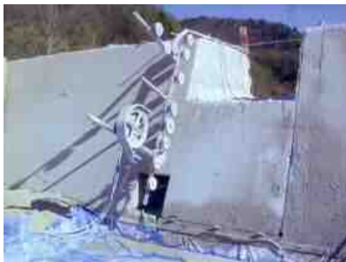
参考写真 ワイヤーソー施工写真
