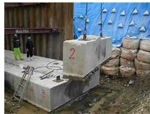
参考写真 コンクリートブロック撤去
