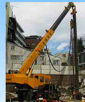
杭打機 ラフタークレーン
