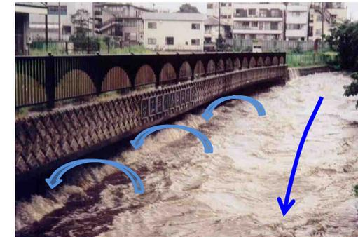
洪水を調節池に流入させ、一時的に貯留することにより、調節池下流側の水位を下げ、安全にします
