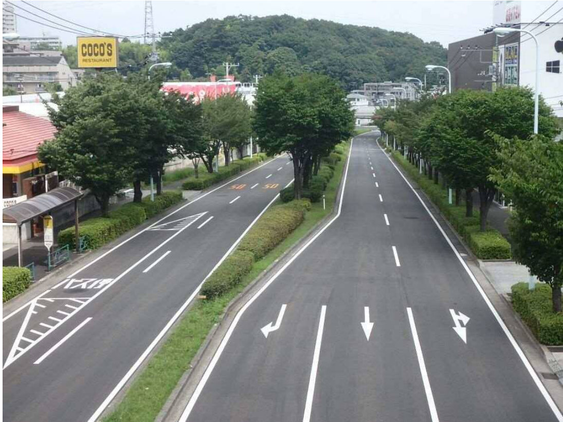
一般都道町田平山八王子線（第155号）平山通り 八王子市別所
