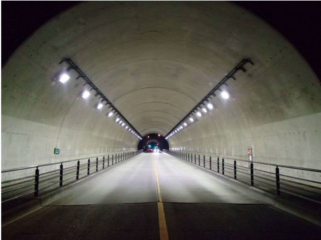
一般都道町田平山八王子線（第155号）平山通り 堀之内第一トンネル
