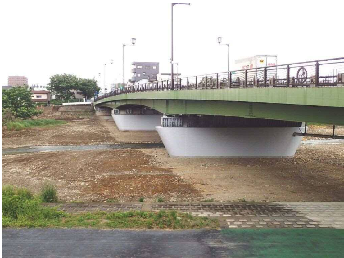
主要地方道八王子五日市線（第32号）秋川街道 萩原橋
