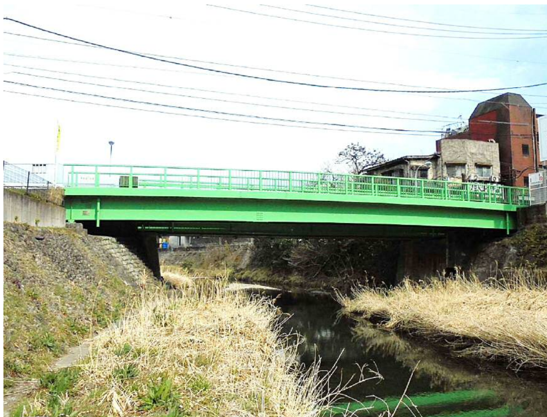
主要地方道八王子あきる野線（第46号）高尾街道 敷島橋
