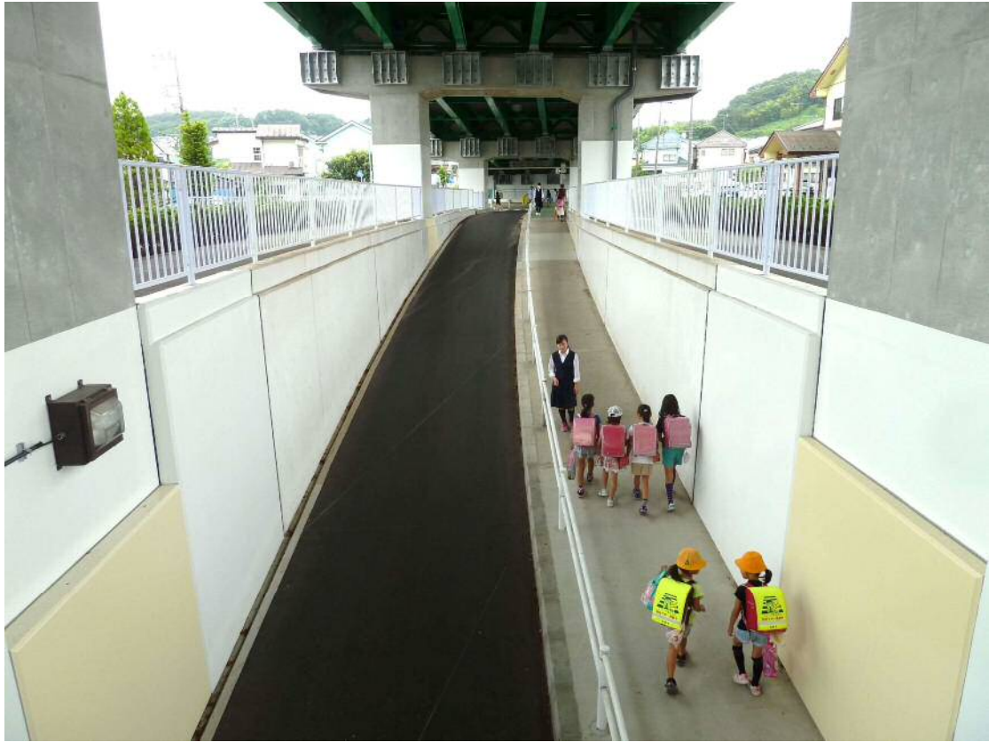
一般都道町田平山八王子線（第155号）平山通り 平山陸橋
