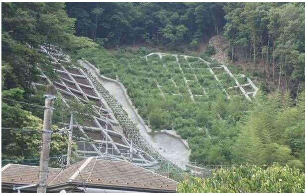
高尾 急傾斜地崩壊防止工事（八王子市高尾町地内）施工状況
