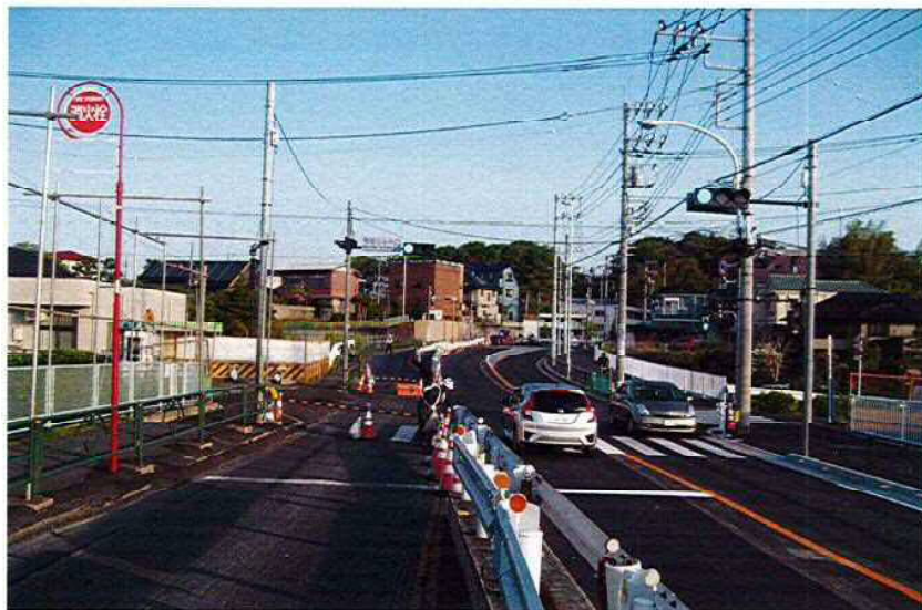
○主要地方道府中町田線（主18号 鎌倉街道）：本町田Ⅱ期 本年度、東側の道下擁壁完了し、歩道整備後、東側に車線切替を実施。
