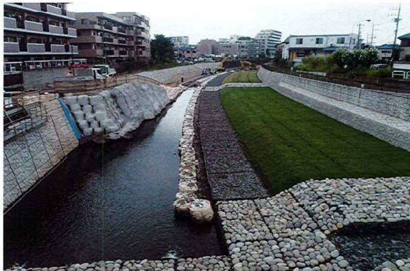
○境川：鶴間橋下流（町田市鶴間） 流下能力不足の区間を1時間50mmの降雨に対応する護岸整備（施工中）。
