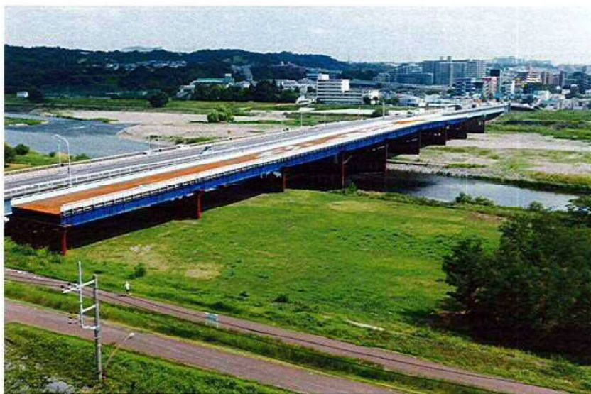
○主要地方道府中町田線（主18号 鎌倉街道）：関戸橋 仮橋7径間の架設を完了。引き続き、残り6径間の架設を進める。
