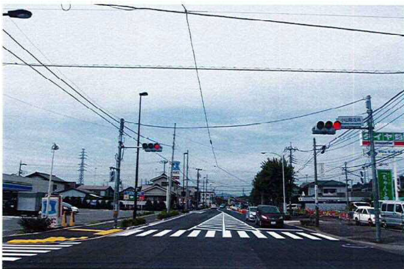
○主要地方道八王子町田線（主47号 町田街道）：小山Ⅱ期 本年度、南側の街築、電線共同溝、舗装整備し、南側に車線切替を実施。
