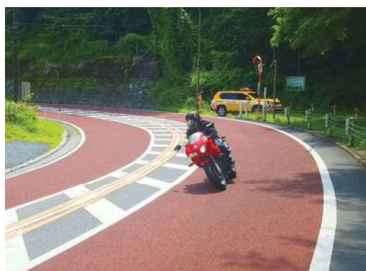
安全施設事業（すべり止め舗装） 「奥多摩周遊道路 3.3kp付近」 平成29年8月撮影（完了）
