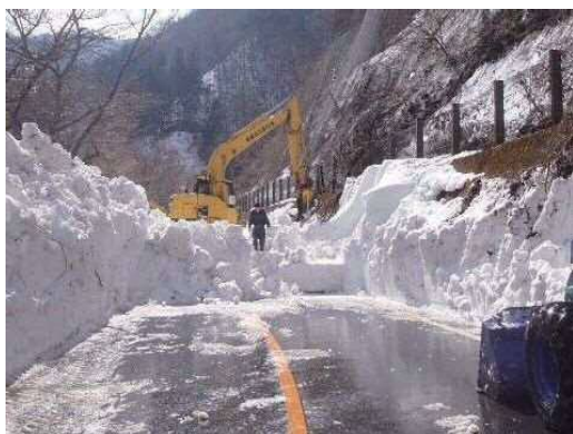
除雪作業 「奥多摩周遊道路」 平成26年3月撮影
