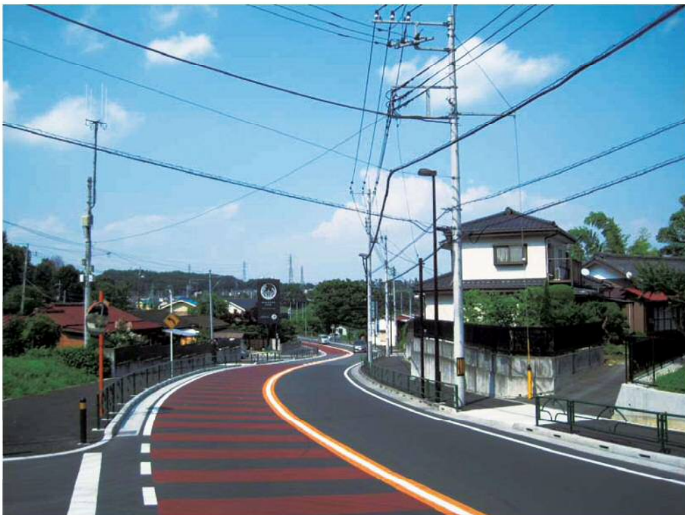
交通安全施設事業(視距改良事業) 「滝山街道(国道411号)」 青梅市友田一丁目地内 平成29年1月完成
