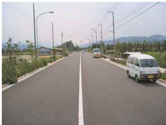
幅員18mで完成した都道伊奈福生線
