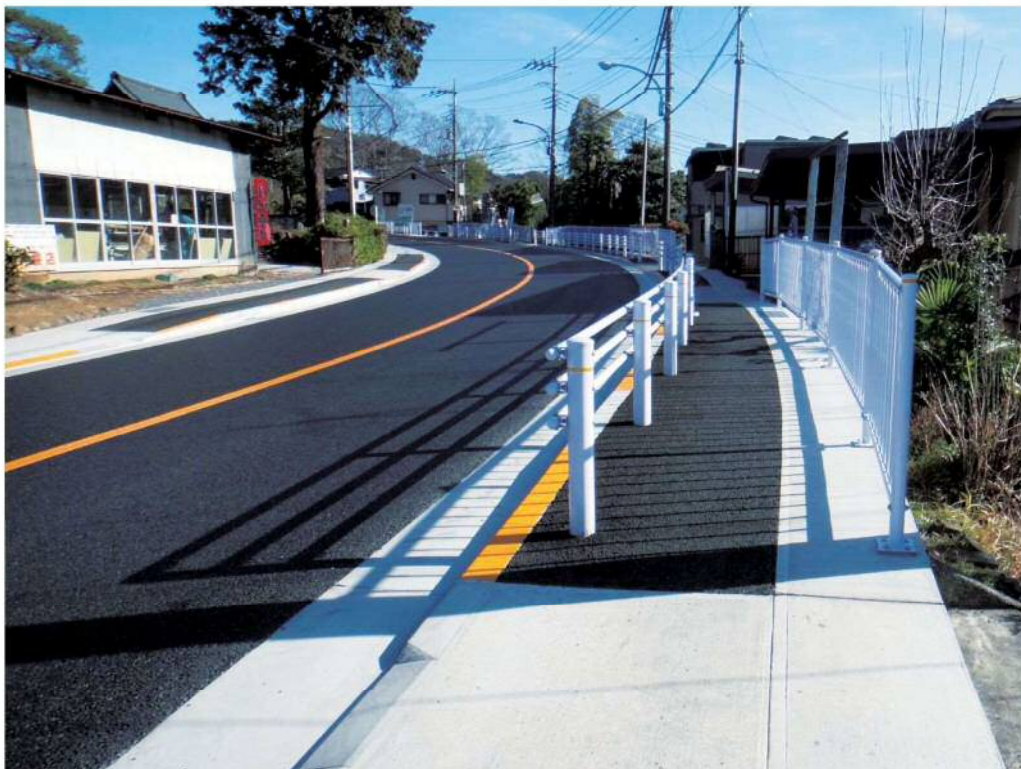
路面補修事業(歩道改善) 「一般国道411号 青梅街道」 青梅市日向和田二丁目地内から同市日向和田三丁目地内まで 平成29年2月完成
