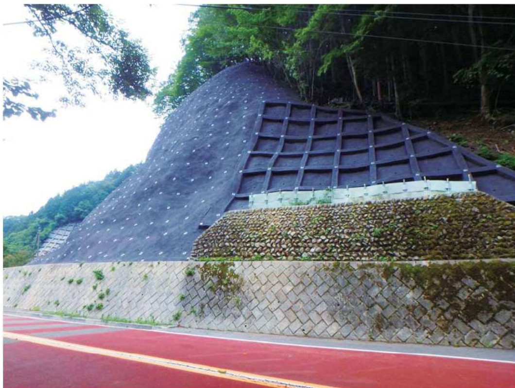
道路災害防除事業 「奥多摩周遊道路 15上斜面」 奥多摩町川野地内 平成29年6月完成
