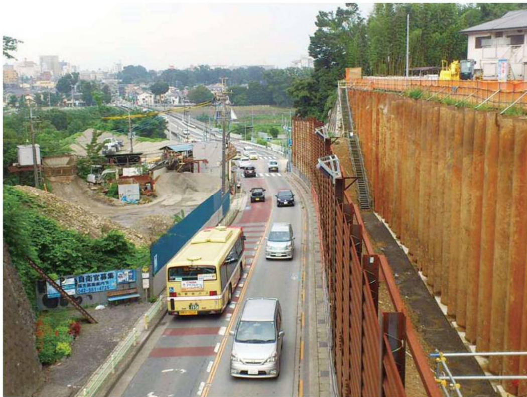
道路整備事業 「一般都道165号伊奈福生線(永田橋通り)」 (あきる野市草花地内) 平成29年7月
