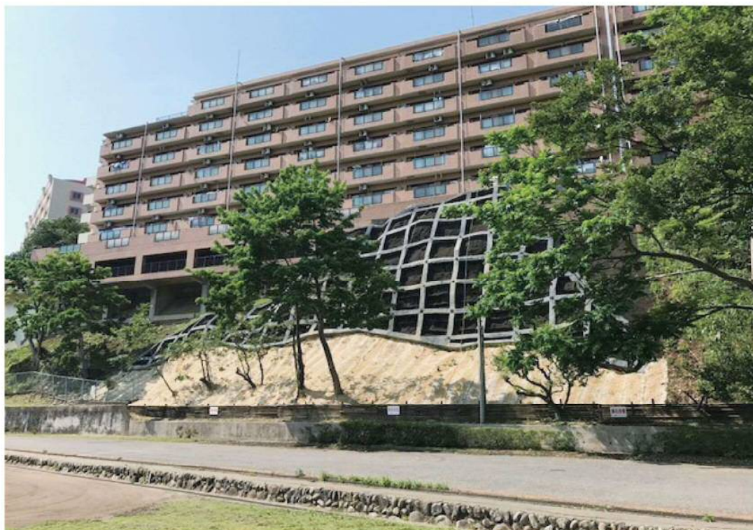
急傾斜地事業 「河辺町一丁目地区」 (青梅市河辺町一丁目地内) 平成29年6月
