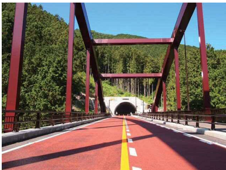
（将門大橋と城山トンネル坑口）
