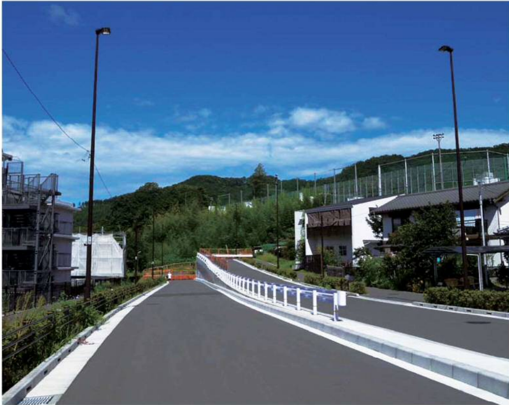
街路整備事業 「青梅3・4・4号」 青梅市滝ノ上町地内から日向和田一丁目地内まで 平成29年7月現在
