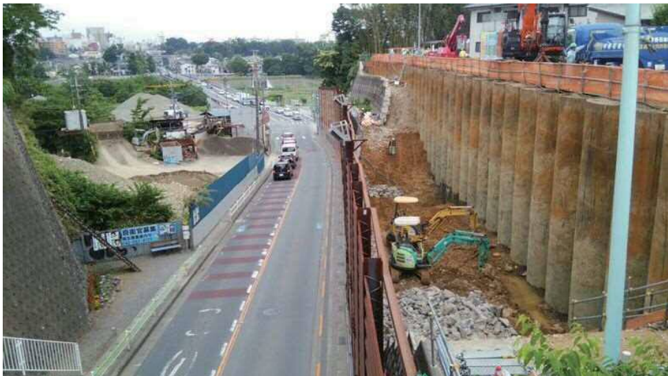
平成28～29年度施工状況（右側の擁壁撤去）
