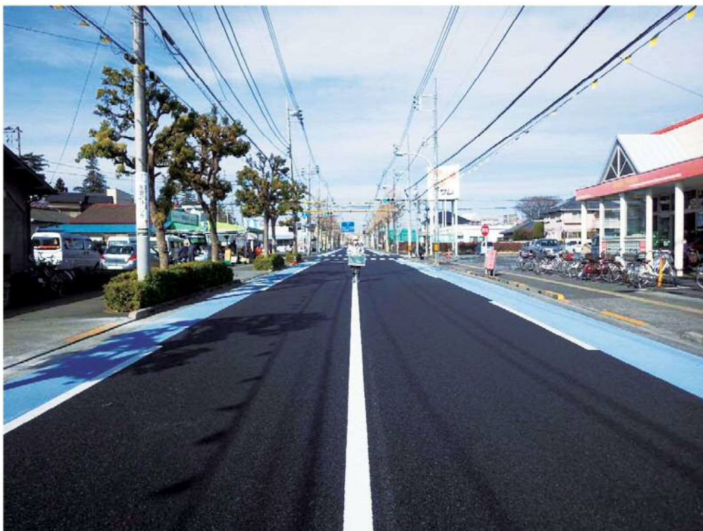
交通安全施設事業(自転車走行空間整備) 「主要地方道立川青梅線(第29号)新奥多摩街道」 羽村市羽中二丁目地内から同市小作台五丁目地内まで 平成29年1月完成
