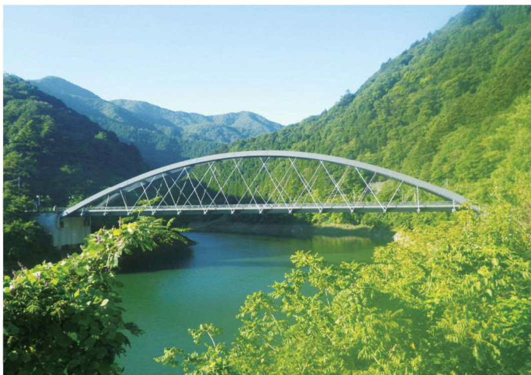
橋梁維持事業(塗装塗替) 「奥多摩周遊道路 三頭橋」 奥多摩町川野地内 平成28年9月完成
