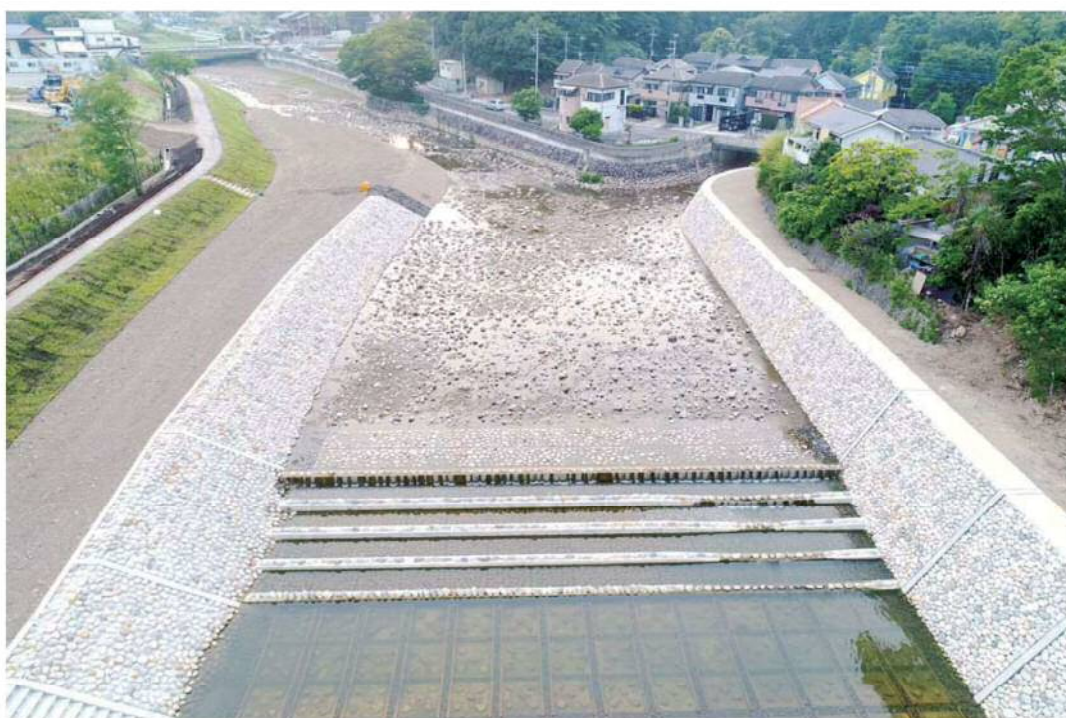
中小河川整備事業 「平井川整備工事」 (あきる野市草花地区) 平成29年7月
