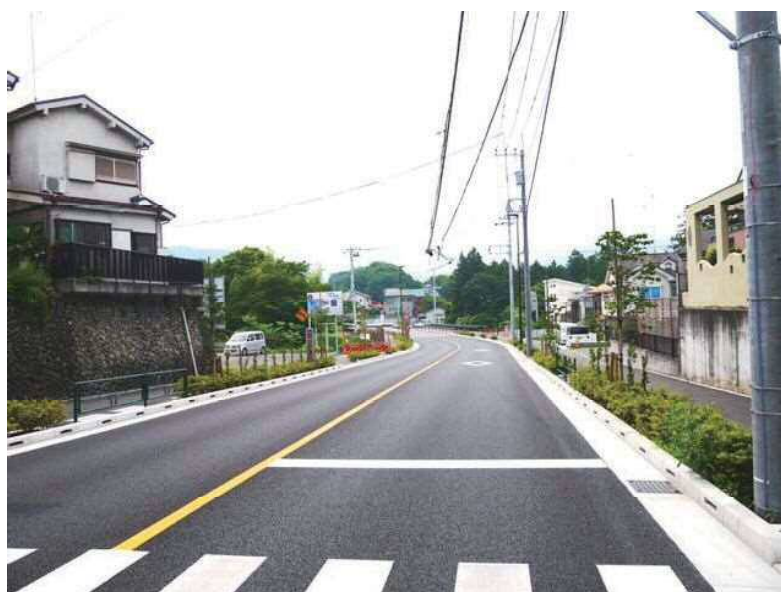
(整備が完了した凱旋橋付近)
