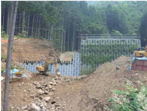
海沢川（えん堤）
