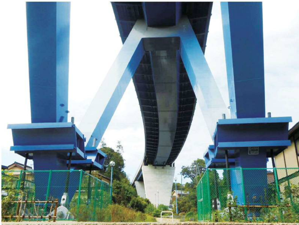
橋梁整備事業(山田大橋耐震補強) 「主要地方道山田宮の前線(第61号)山田通り」 あきる野市山田地内から同市網代地内まで 平成29年1月完成
