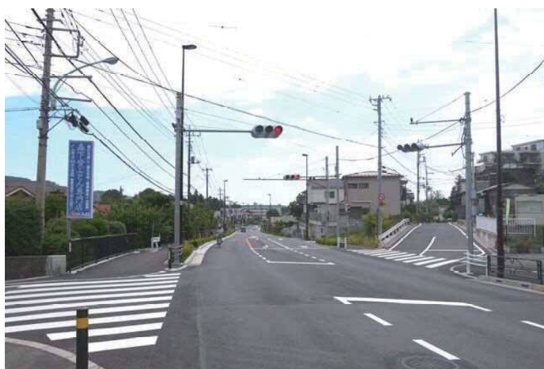
整備が完了したⅠ期区間
