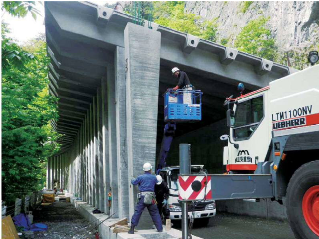
道路災害防除事業(洞門) 「一般都道日原鍾乳洞線(第204号)日原街道」 西多摩郡奥多摩町日原地内 平成29年5月現在(事業中)
