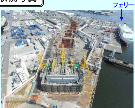
○ふ頭用地が南北線工事ヤードとして利用（H29.7 撮影）
