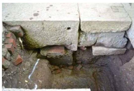
図3-4 試掘調査による唐門跡基壇部下層の煉瓦による基壇補修跡
