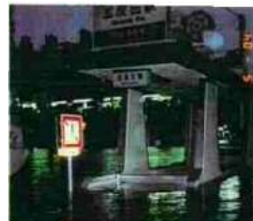
平成元年浸水状況
